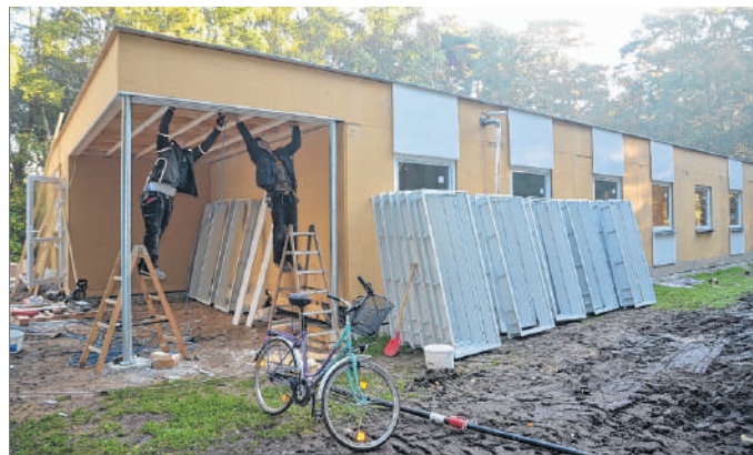
Am Schwarzen Weg sind die Handwerker dabei, das erste mobile Wohnheim zu erstellen. Foto: Caroline Theiling
