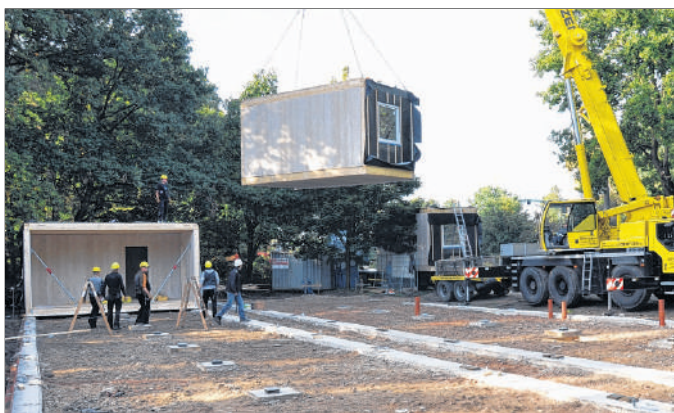
Der Aufbau des modularen Wohngebäudes in Darme hat begonnen. Modul für Modul wird von einem Kran auf das vorgefertigte Fundament gesetzt und verankert. Foto: Felix Reis
