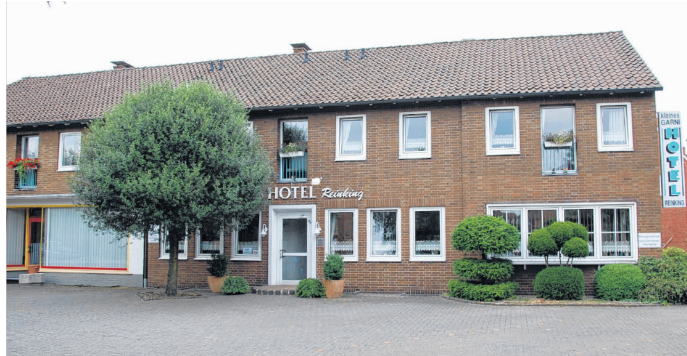
Das ehemalige Hotel Reinking an der Straße „Am Telgenkamp“ in Lingen wird umgebaut und soll künftig bis zu 25 Flüchtlinge beherbergen. Das wurde im Finanzausschuss des Lingener Rates bekannt gegeben.
