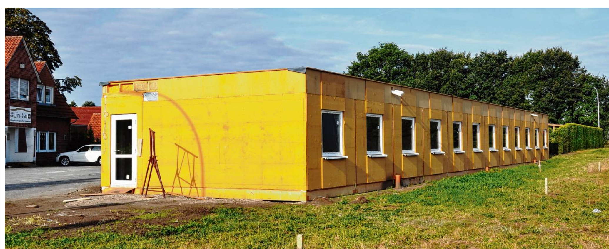
Zurzeit wird ein Wohnheim für Flüchtlinge im Lingener Ortsteil Brögbern errichtet.
