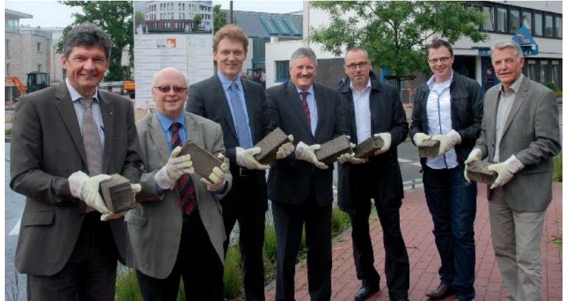
Entfernten vor dem Spatenstich die letzten Steine: von Caritasdirektor Franz Loth, SKM-Vorsitzender Heinz Rolfes, Oberbürgermeister Dieter Krone, Landrat Reinhard Winter, Architekt Hannes Remmers, Bauleiter Frank Exeler und SKM-Geschäftsführer Günter Rohoff.
