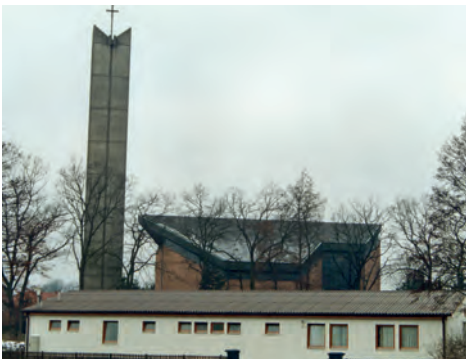
Das Flüchtlingswohnheim an der Teichstraße
