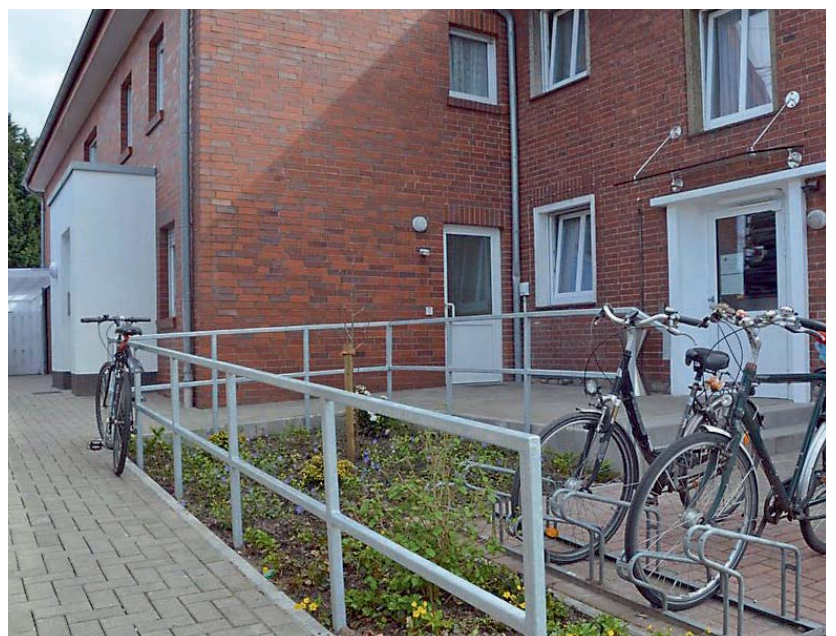
Barrierefrei kommt man jetzt in die Räume des Korczak-Hauses zur Übernachtungsstelle und zum Tagesaufenthalt an der Rheiner Straße. Links ist der Eingang zur Frauenunterkunft zu sehen (weißer Mauervorsprung)
